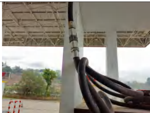
图 10 加油机加油软管拉断阀
