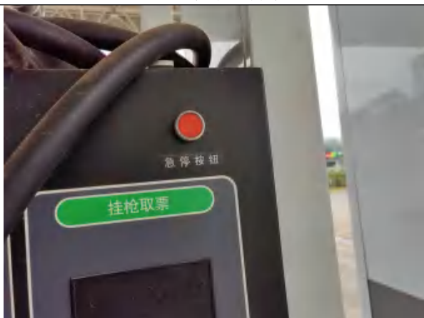
图 9 加油机急停按钮
