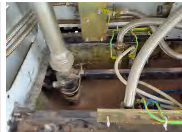
图 7 加油机内部剪切阀
